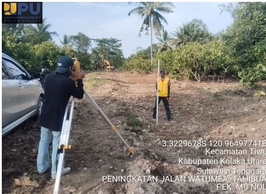
Gambar 2 Pembangunan Ruas Jalan Watumea – Tahibua Sumber : Dinas PUPR Kab. Kolaka Utara (2026)
